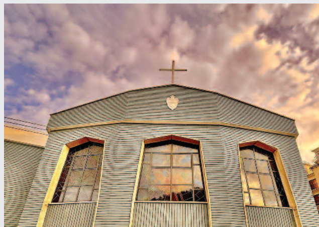
La facciata della parrocchia di San Vincenzo Pallotti a Napoli
